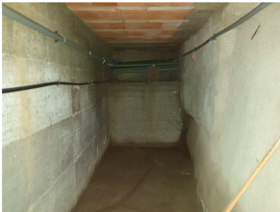
Vista 6 – Piano Seminterrato (Scannafosso)
