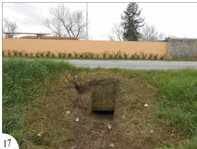
Fig. 15 – Attraversamento idraulico n.10
