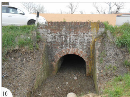
Fig. 12 – Attraversamento idraulico n.9
