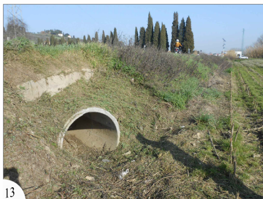
Fig. 8 – Attraversamento idraulico n.7
