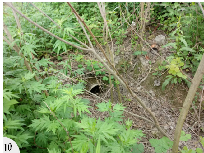
Fig. 6 – Attraversamento idraulico n.6
