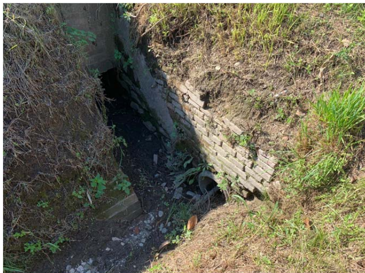
Fig. 4 – Attraversamento idraulico n.1 e n.2
