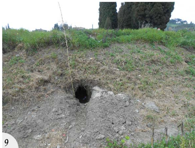
Fig. 9 – Attraversamento idraulico n.5
