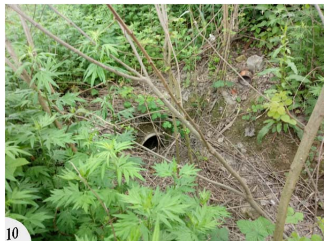
Fig. 11 – Attraversamento idraulico n.6
