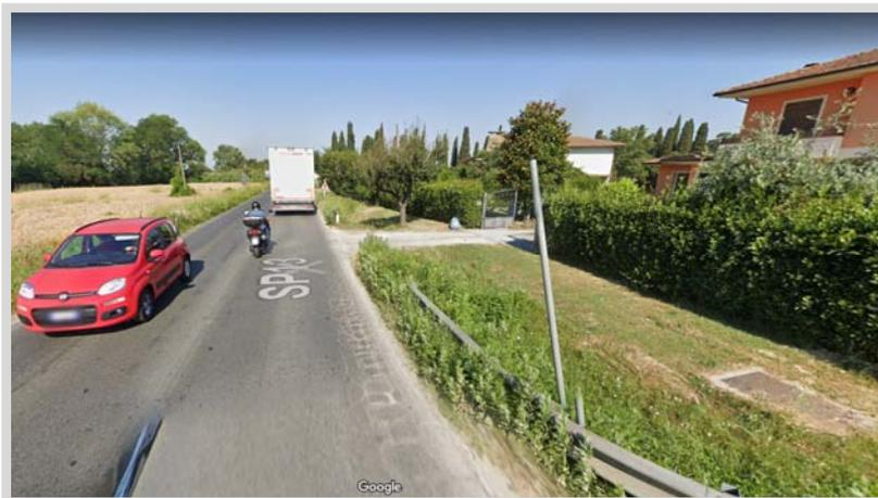
Al termine di questo tratto, siamo in presenza ad un perimetro esterno della S.P. 13 costituito da aperta campagna, con un piano coltivato impostato ad una quota inferiore a quella del piano stradale che in quel tratto corre in leggero rilevato di altezza poco superiore ad 1 m.
