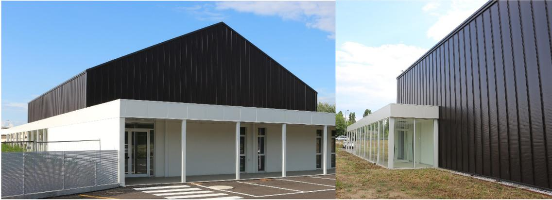
Figura 6 - Immagine di esempio facciata con rivestimento metallico Riverclack, progetto Gruppo Marche
