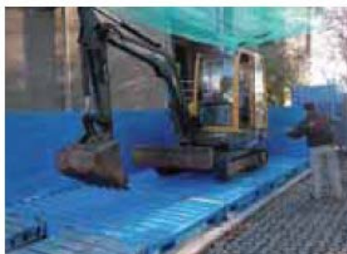
Figura 10: Sistema di lavaggio a ciclo chiuso
